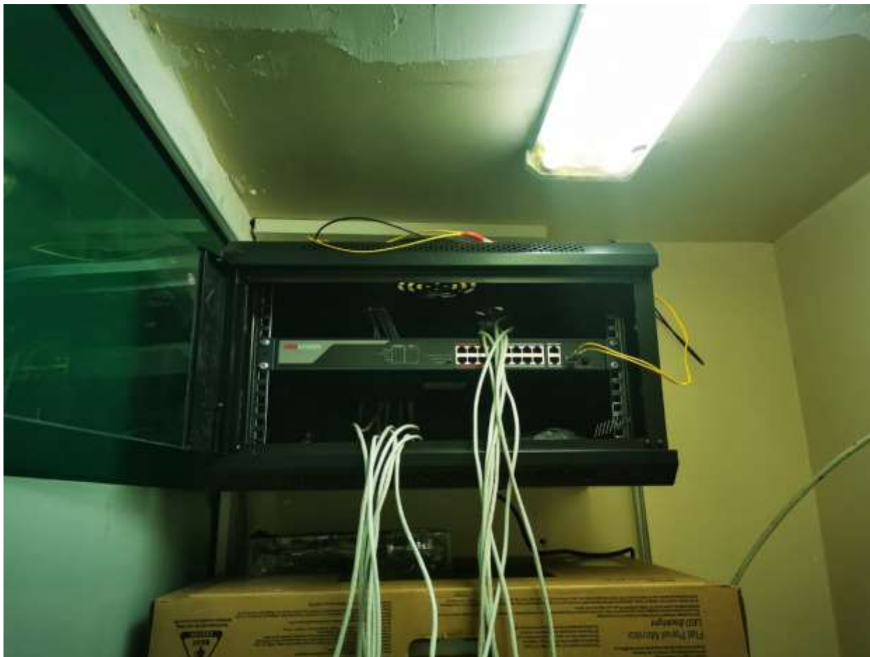
14-сурет- Коммутаторды телекоммуникациялық шкафқа орнату
